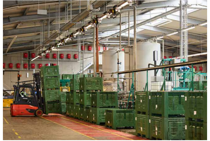
Im Übergabebereich zählen sichere Prozesse – Personen dürfen nicht unbemerkt in den Gefährdungsbereich gelangen. Zugangssicherungen von Leuze sind oberhalb der Stationen installiert.
