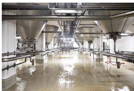
In den 39 riesigen Lager-tanks gärt das Bier, bevor es zur Abfüllung gepumpt wird.
